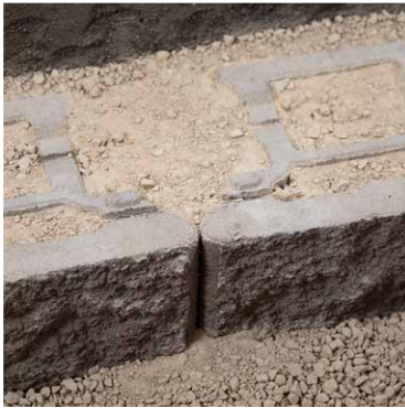
Diagram 5 - Core Fill
