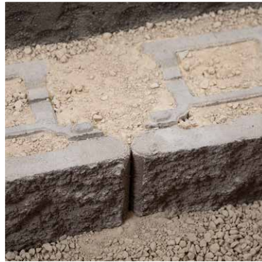
Diagram 5 - Core Fill
