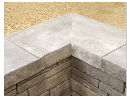
Diagram 11—45-degree miter
